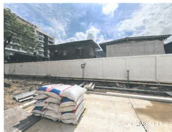
รูปที่ 2-2 แสดงรั้วที่บับเมทัลชีท (Metal Sheet) รอบพื้นที่ก่อสร้าง
