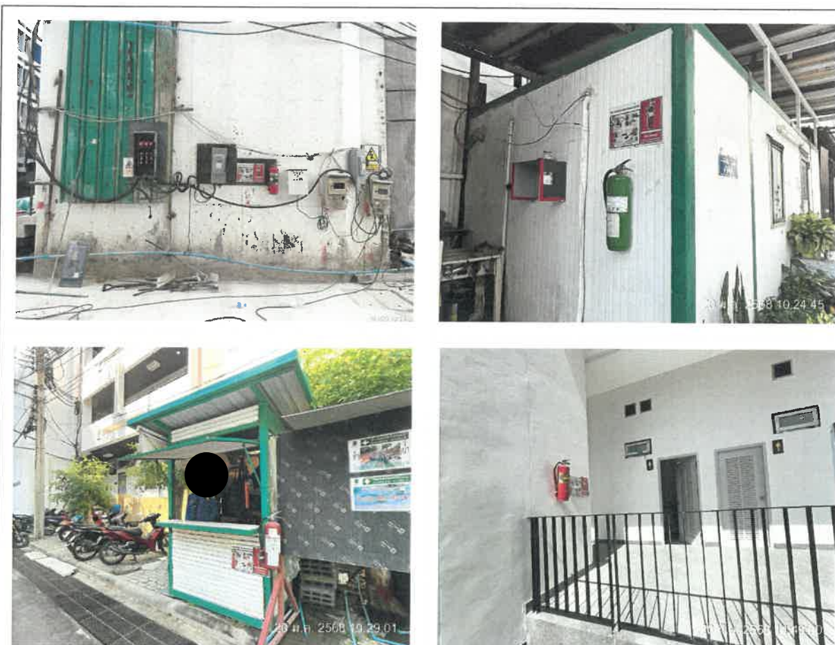
รูปที่ 2-56 แสดงถึงดับเพลิงชนิดผงเคมีแห้ง พร้อมป้ายแนะนำการใช้งาน
