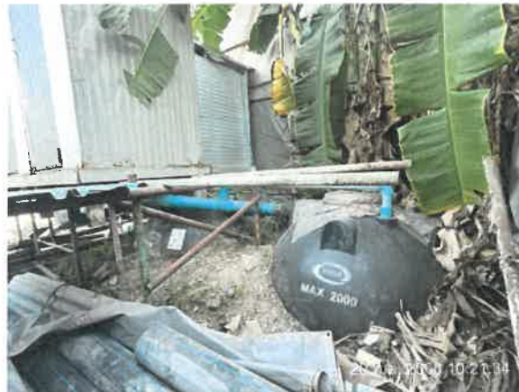
รูปที่ 2-23 แสดงระบบบำบัดน้ำเสียสำเร็จรูปภายในโครงการ
